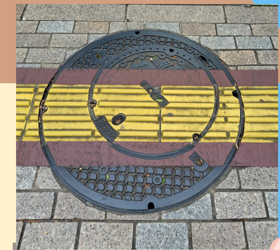
お台場海浜公園駅付近に設置された親子蓋
