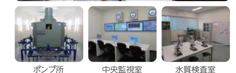
ポンプ所 中央監視室 水質検査室
