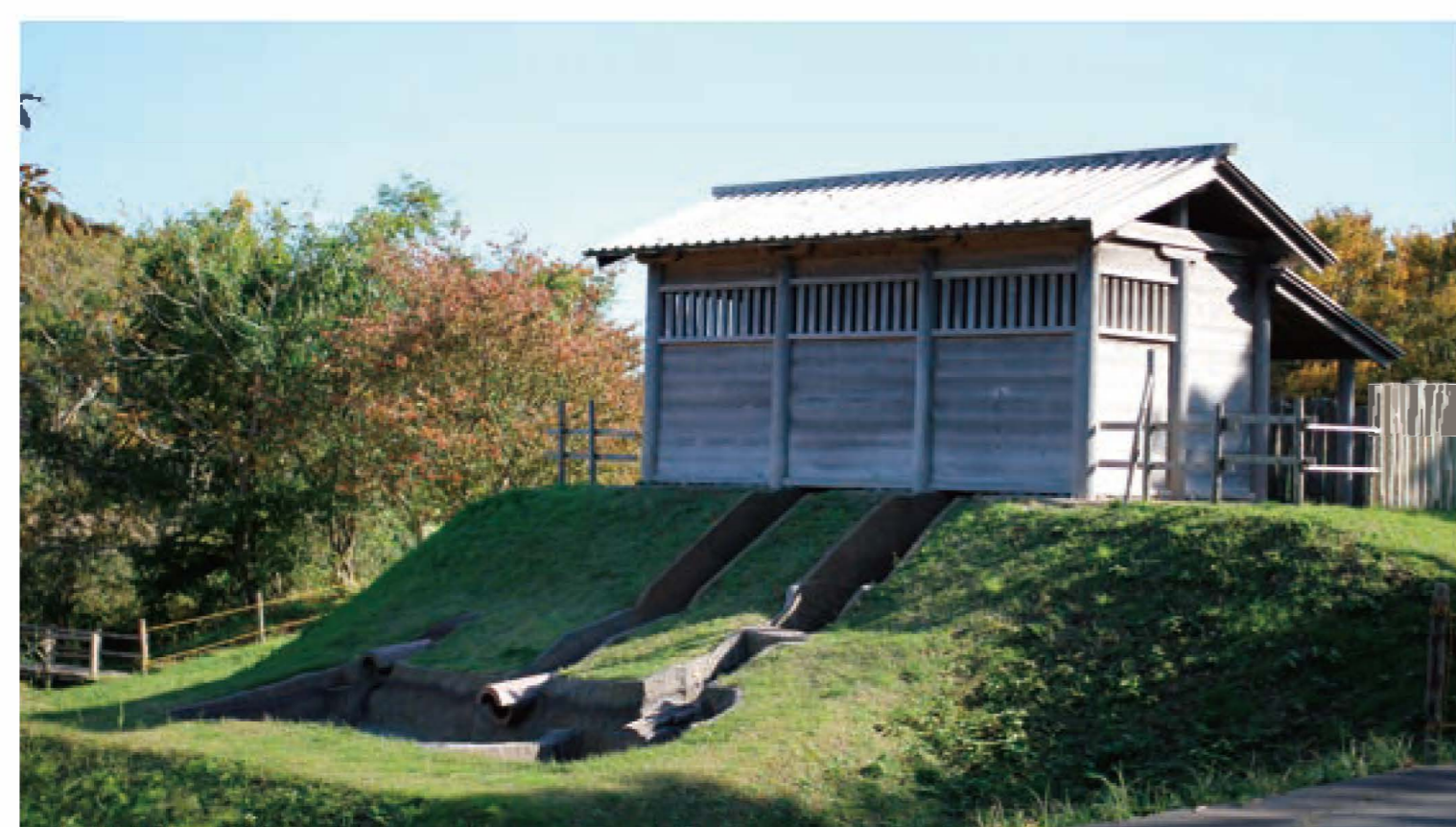
▲復元された奈良時代水洗廁舎(秋田城址)
