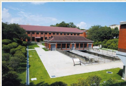
▲旧三河島汚水処分場唧筒場施設 (東京都荒川区)
