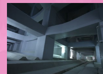
▲芝浦雨天時貯留地 芝浦水再生センターの地下にある雨水貯留施設 25mプール約160杯分の雨水をためることができます
